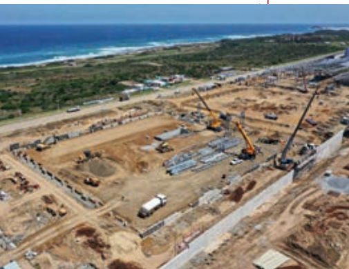
Es geht voran: Baufortschritt am neuen Standort von POLYTEC in Südafrika
