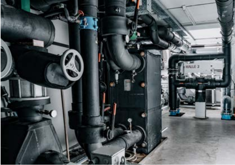
Zur Kühlung der Spritzgussmaschinen wird im Werk Ebensee Grundwasser eingesetzt.
