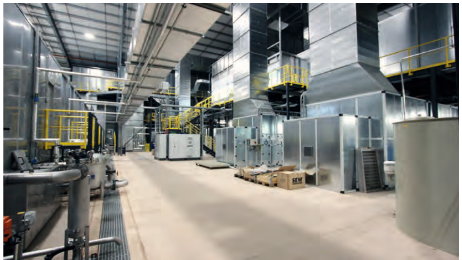
Neue Werkhalle am Standort Telford
